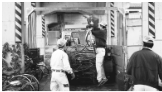
放置自転車の処分作業
