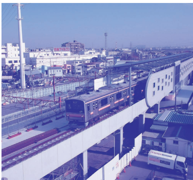
JR南武線高架下り線(立川方面)南多摩駅付近
