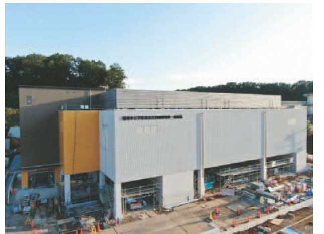
建設中の稲城市立学校給食共同調理場
