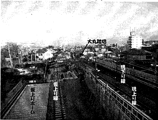
仮上りホーム、仮上り線路が敷かれた南多摩駅
