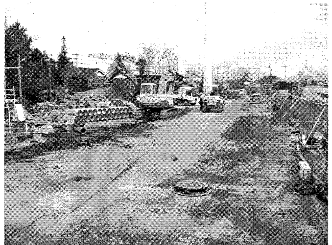
多3・4・11号線の工事状況
