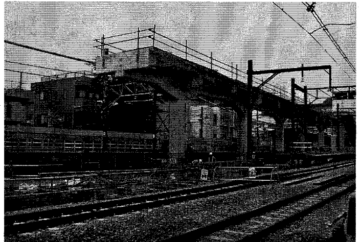
高架橋築造の様子
