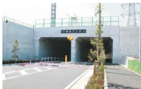
▲坂浜・平尾地区をつなぐ小田良トンネルが開通
