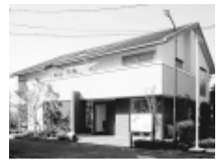
太陽光発電システム
