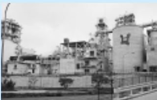
エコセメント化施設
