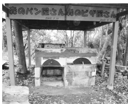
▲完成したピザ釜
