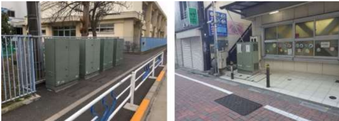
図 11 公共用地等への地上機器設置事例
