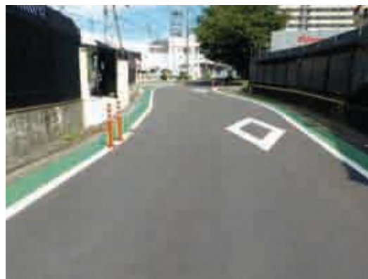
ポストコーン及びカラー舗装の設置例
