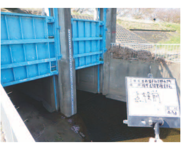
定期的に点検を行っている大丸谷戸川の樋門
