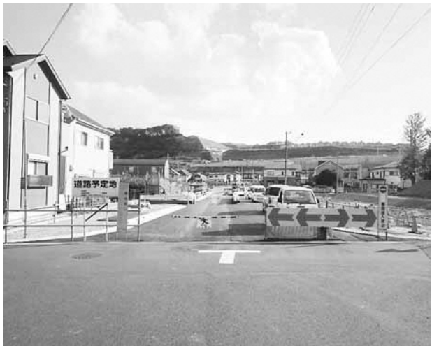
道路の開通に向けた工事が進んでいる多7・4・5号線
