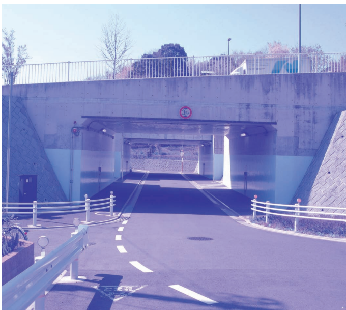
▲尾根幹線川北下地下通路
