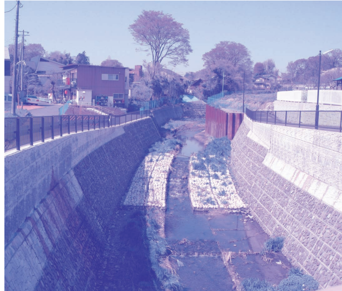
▲三沢川 新きさらぎ橋上流
