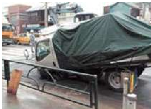
【管きよの老朽化に伴う道路陥没事例】
