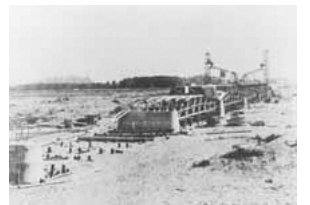
▲多摩川原橋の建設工事
