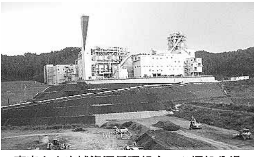
▲東京たま広域資源循環組合二ツ塚処分場
