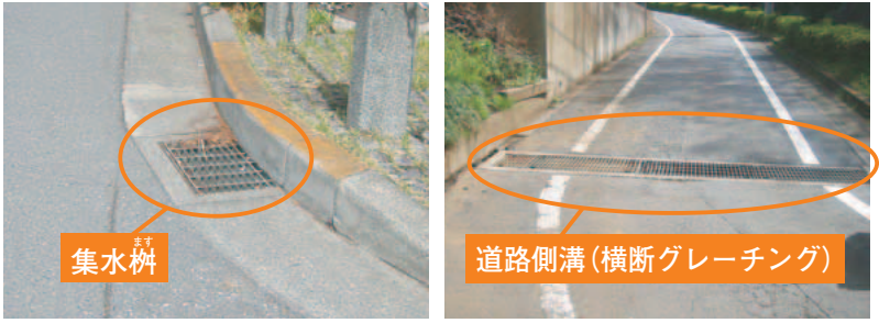
道路側溝の一例
