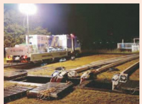
▲ポンプ車による排水作業
