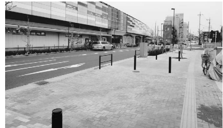
▲歩道のインターロッキングブロックにエコセメントが使われています(JR南武線矢野口駅周辺)
