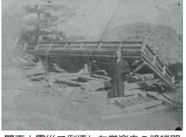
関東大震災で倒壊した常楽寺の鐘楼門
