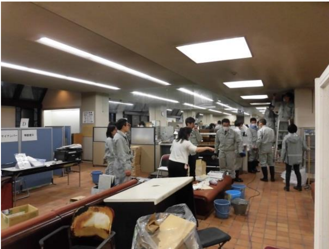
1階フロア復旧作業②
