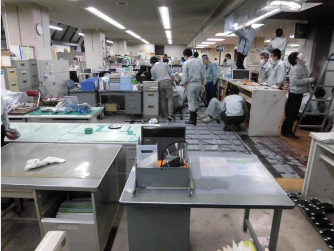
1階フロア復旧作業③
