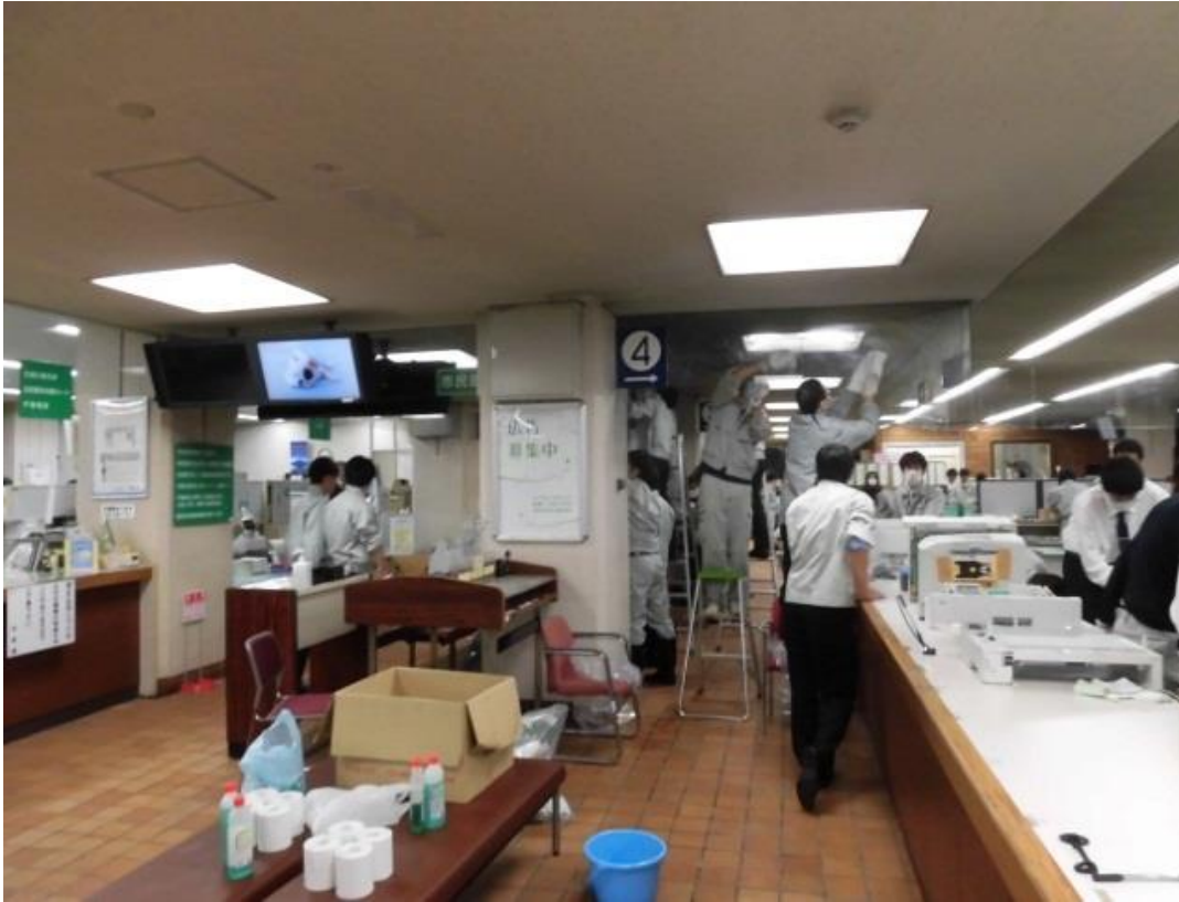
1階フロア復旧作業①
