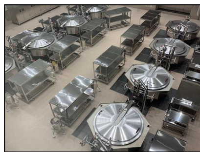
▲3階会議室の見学・体験スペースから見た2階の調理室(第一調理場)
