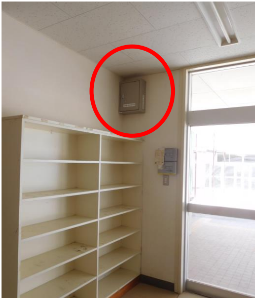
体育館出入口付近
