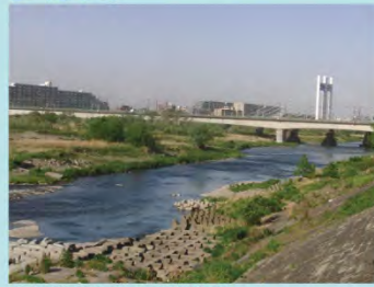
是政橋上流付近
