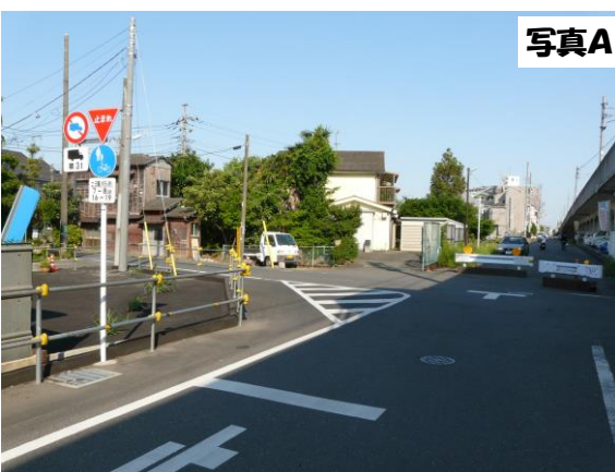
【① 交差点改良工事】
