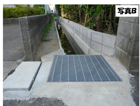
【② 水路改修工事】
