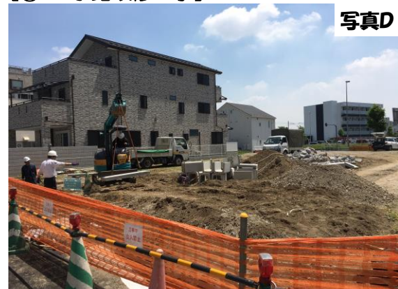
【④ 整地工事】
