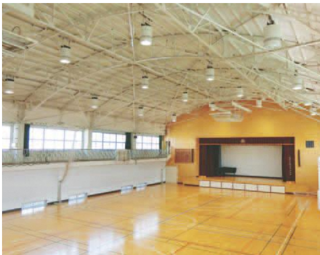
空調設備が設置される学校体育館 (稲城第一中学校)
