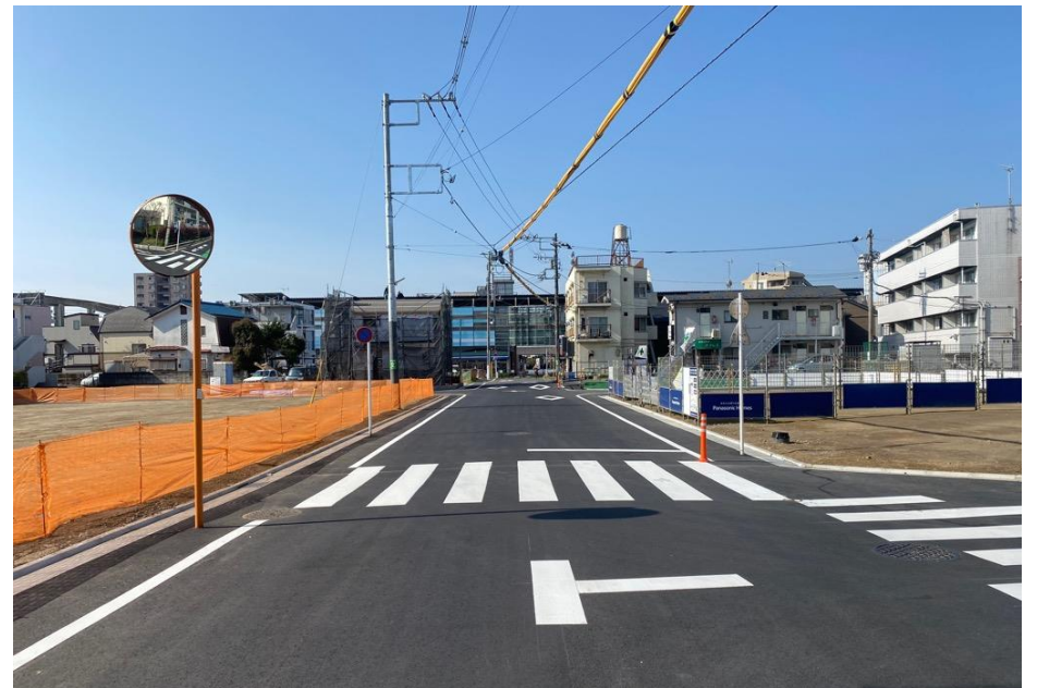
整備後の写真
