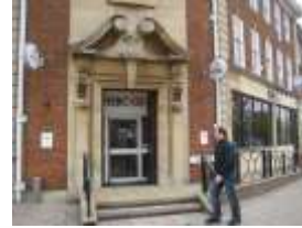
建物右側にスロープを設置
