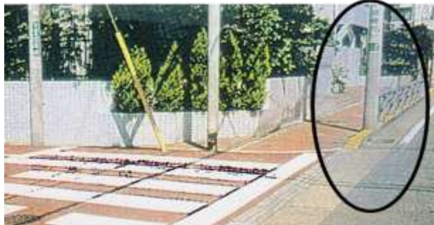
歩道の工夫：段差のない歩道 電柱・ガードレール・がい渠ブロックが一直線
