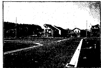
28街区周辺の宅地整地状況
