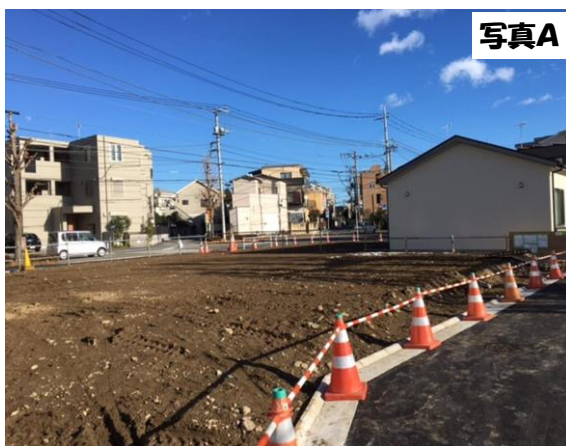
【① 道路築造工事・整地工事】
