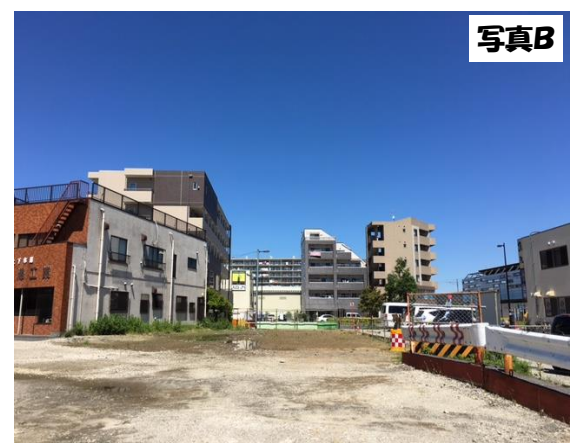
【② 整地工事】
