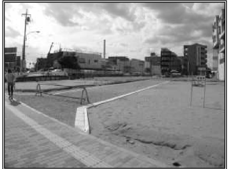
【駅前ロータリー東側の整地状況】写真 B
