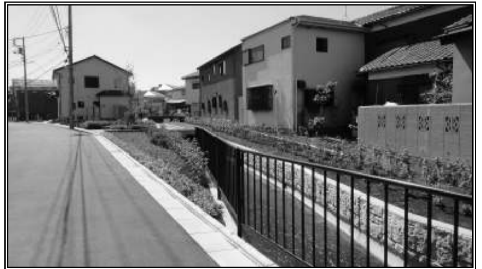
【 整備が完了した中野島用水路 】 写真 A
