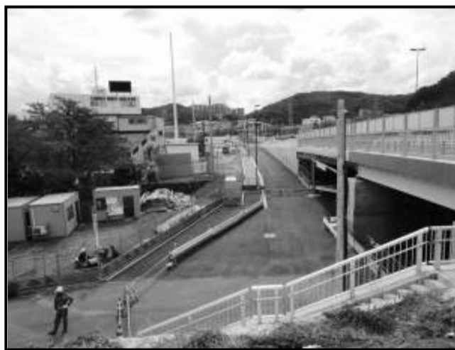
写真D 下流側の側道の状況
