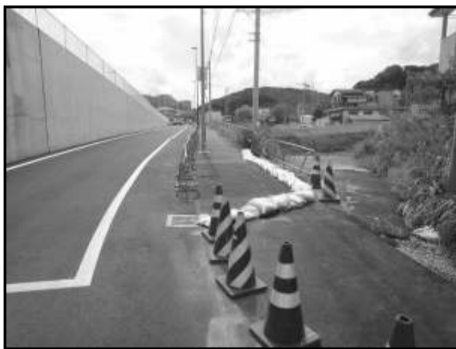
写真C 上流側の側道の状況
