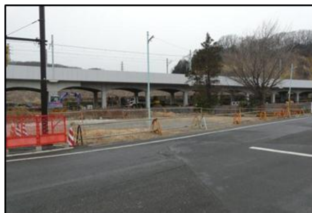
写真B 10街区工事箇所
