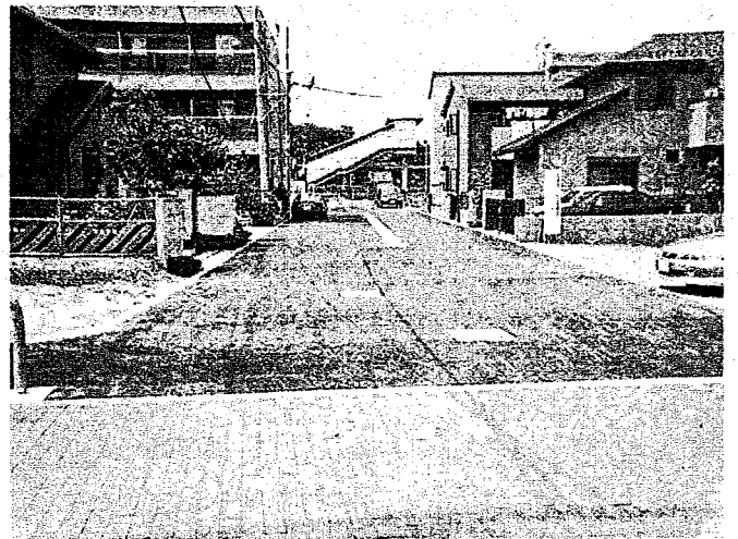
川崎街道に接続された8m道路
