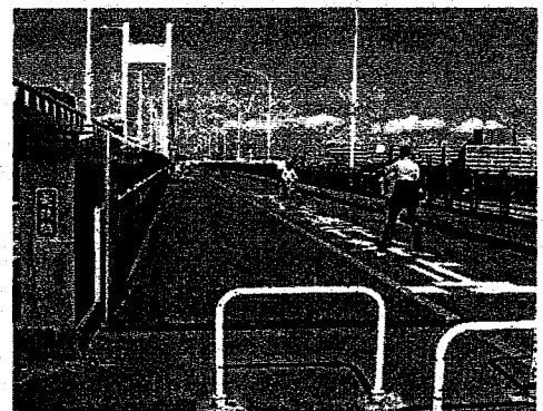
解体工事着手前の是政橋(旧橋)
