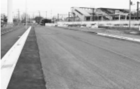
整備が進む南多摩駅周辺
