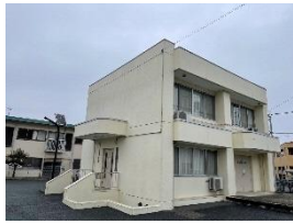
【矢野口コミュニティ防災センター】
