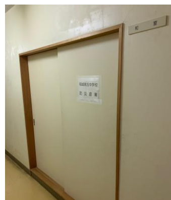
防災倉庫(旧和室)
