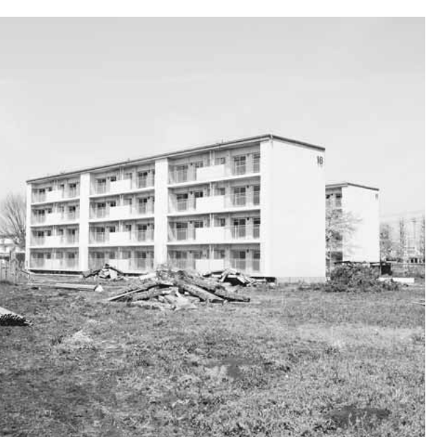
大丸都営アパート跡地
