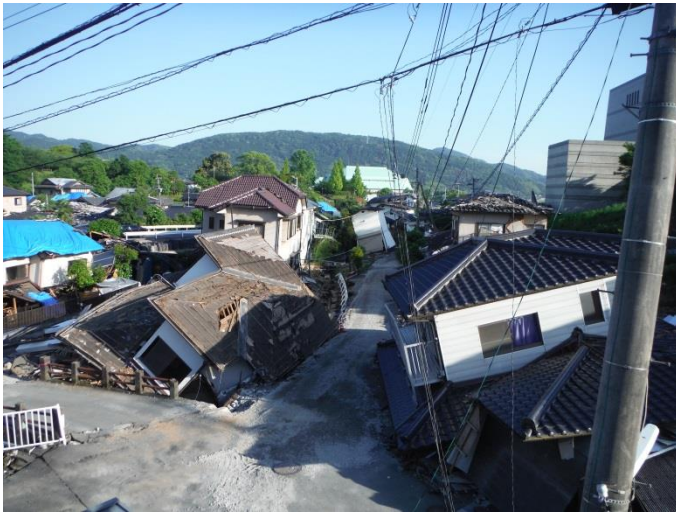
（多くの家屋が倒壊している様子）
