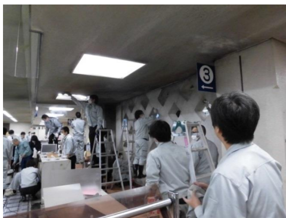
※1階フロアの復旧作業の様子
