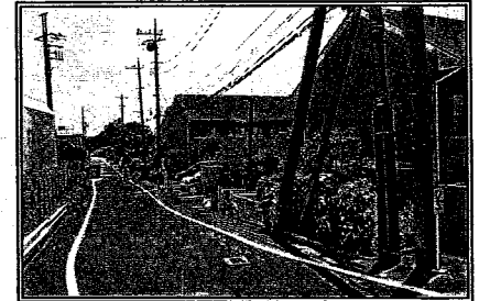
【整備が必要なC工区の様子】
