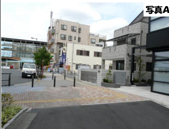
【駅前広場工事】
