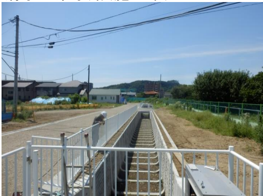
清水川系水路(施工中)
