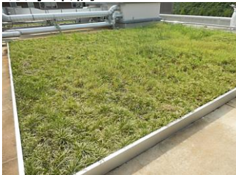
市立病院外来棟屋上
