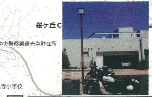
A 公園灯LED化工事
