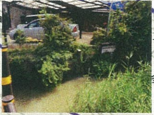
6 公水路維持補修等工事
