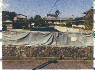
3 多7・5・3号線新設整備事業
