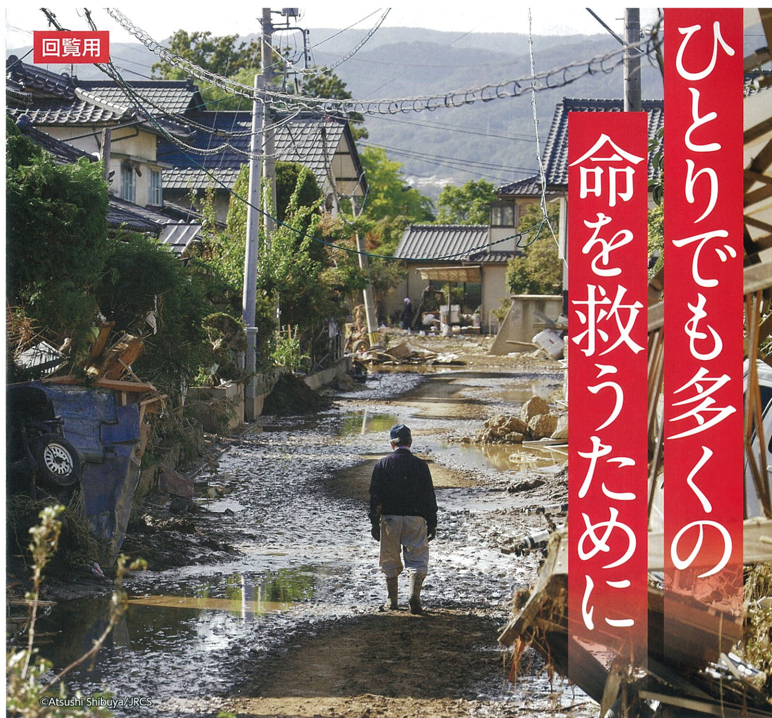
令和元年台風第19号災害で氾濫した千曲川の爪痕(長野市穂保地区)
